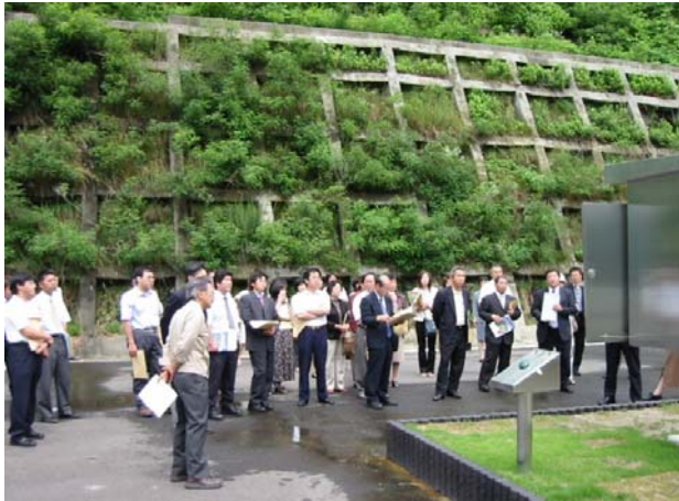
H17.07.01 宮城県鹿島台東部土地改良区 【新宮川ダム】
