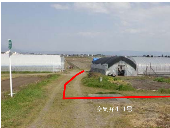
O201工事箇所
