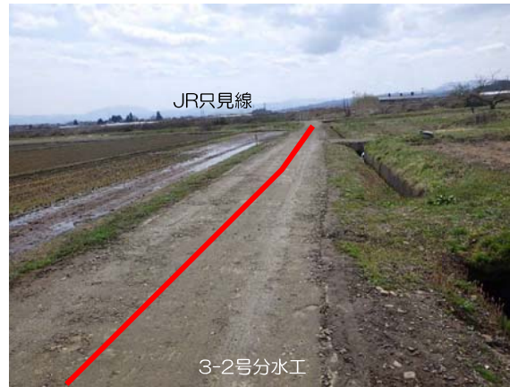
O101工事箇所
