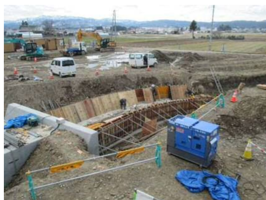
水路接続状況
