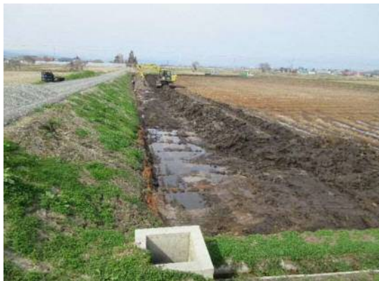
補完工事状況
