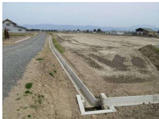
整地工完了後
