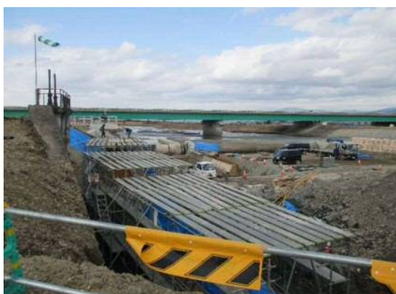
ゴム堰設置状況
