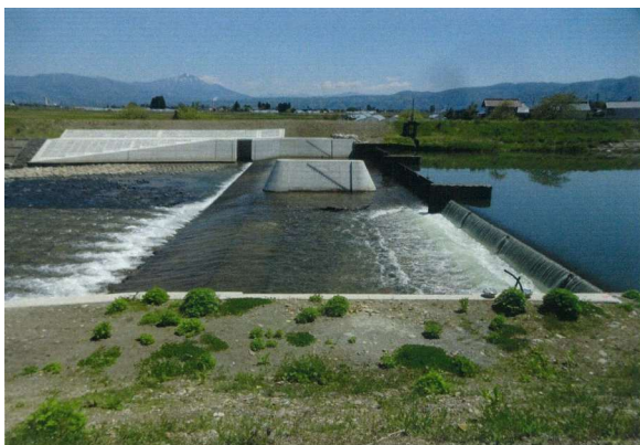
堰体工、右岸護床工
