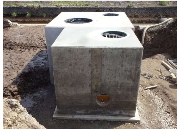
揚水機基礎工
