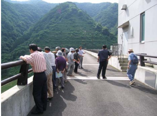
H21.07.26 会津美里町沖ノ館地区 (農地・水)
