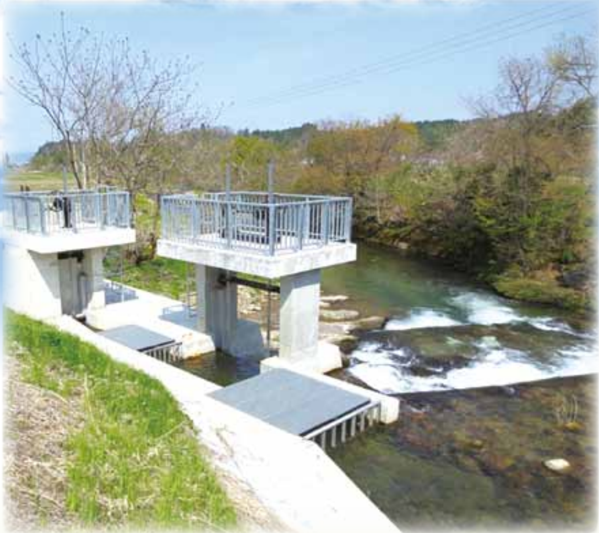
三貫頭首工 左岸取水工竣工
