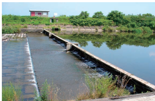
施工前(左岸から望む)
