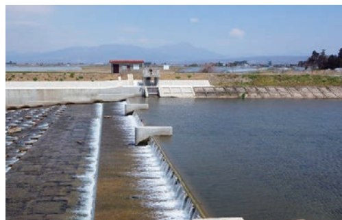
施工後(左岸から望む)
