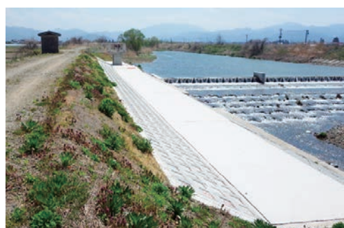
施工後(右岸下流から望む)
