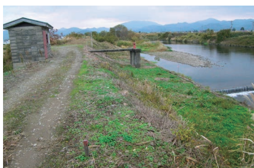
施工前(右岸下流から望む)
