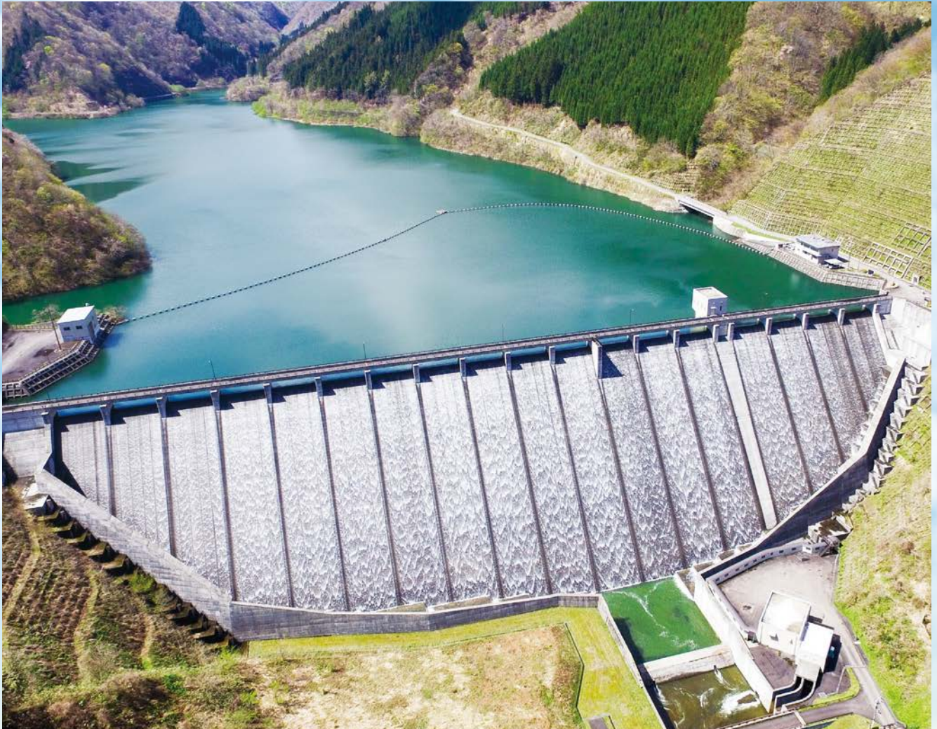
4月 新宮川ダム(上空より撮影)
