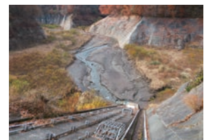
二岐防災ダムの堆砂状況
