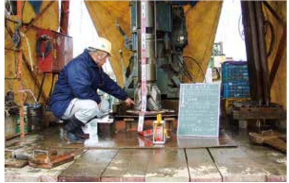
掘削深度確認(掘削深度 101.16m)
