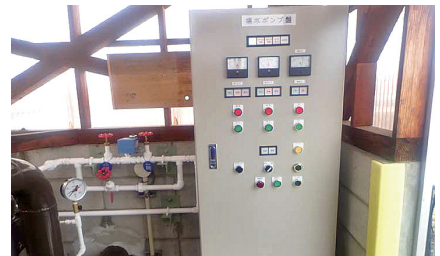
施工後（操作盤）
