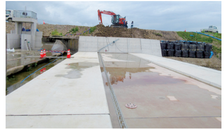
堰本体（ゴム堰）基礎工
