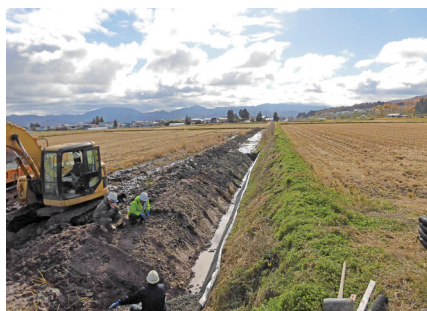
補完工(湧水処理)
