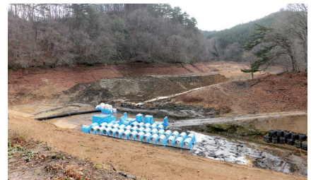
底樋管（プレキャスト管）準備工
