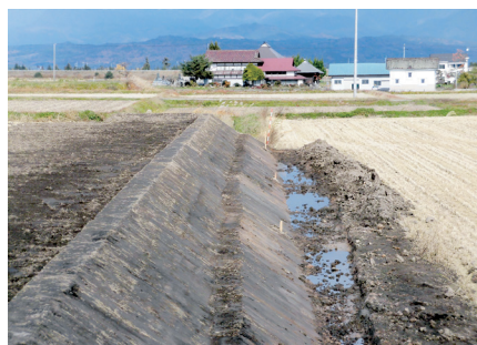
補完工(法面整備)
