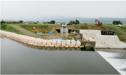
本体工（堰体、取水口、仮設（仮返し））
