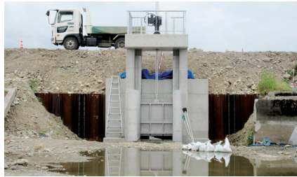
取水口工（左岸）
