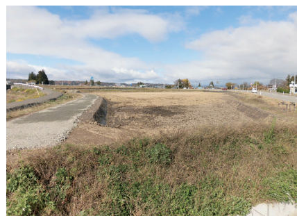
補完工(石礫除去・作業道路整備)
