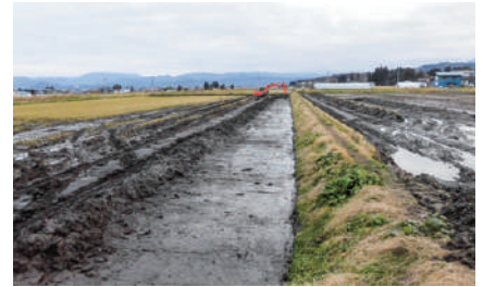
補完工(暗渠排水)
