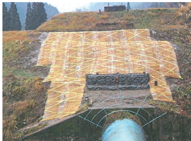
復旧工事終了
