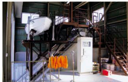
係船設備内部
