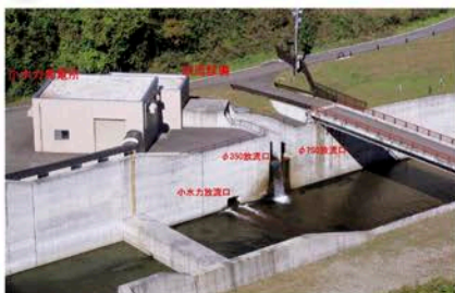
放流設備上屋(小水力発電所含む)
